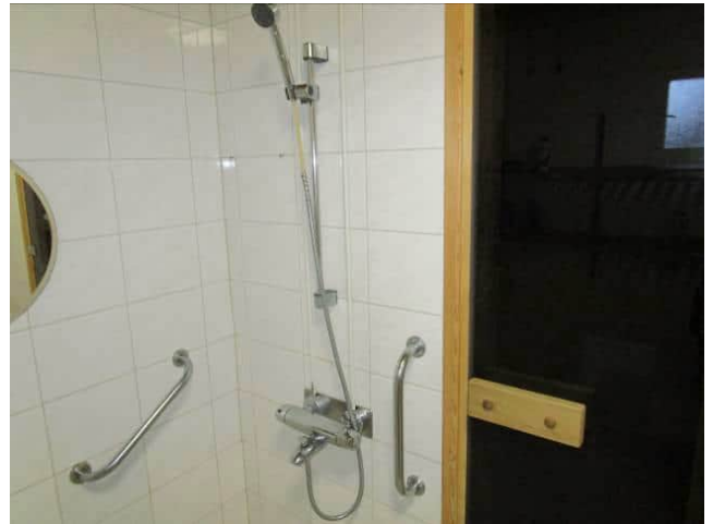
Kuva 6.52 Suihkun vesikaluste
