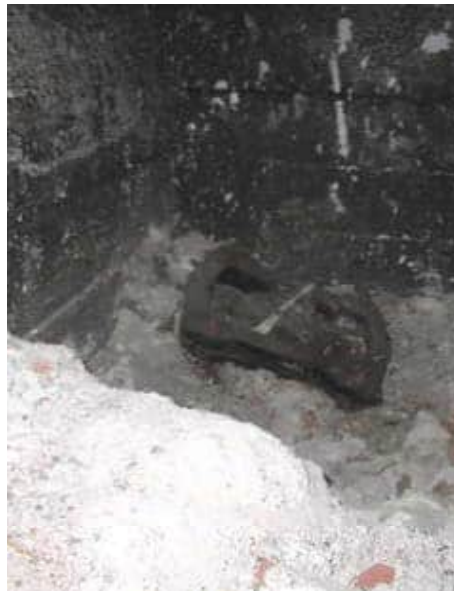
Kuva 2: Viemäriinjan puhdistusyhte kellararkistossa
