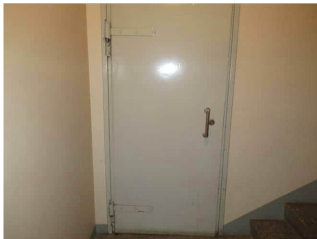
Kuva 6.39 Kellarin metallinen väliovi porrashuoneeseen.
