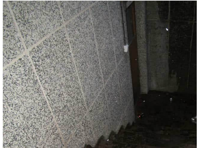
Kuva 6.15 Kellarin seinän ulkopinnassa on kivilevyt.
