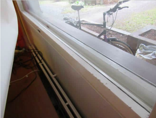
Kuva 6.22 Yleiskuvaa rakennuksen ikkunoista.
