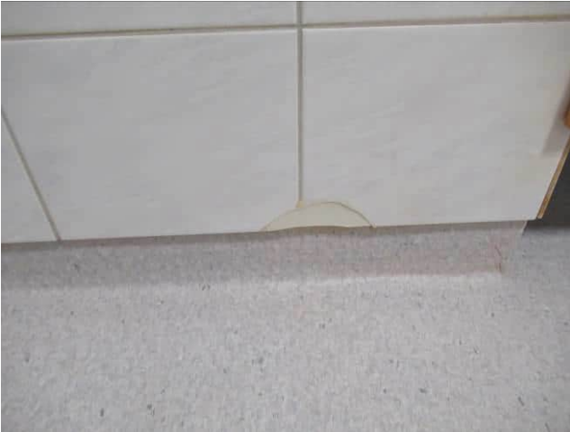
Kuva 6.36 Seinälaatatassa halkeamia.
