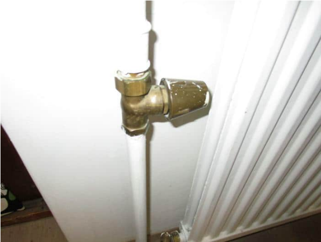
Kuva 6.41 läkäs käsinsäädettävä patteriventtiili
