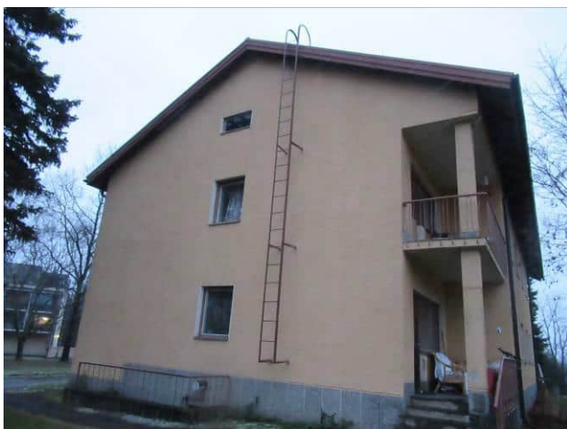
Kuva 6.35 Talotikkaat rakennuksen päädyssä.
