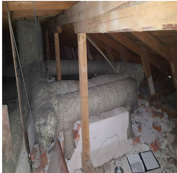
Kuva 102. IV-metallikanavien liitos vanhaan tiilirakenteeseen ilmanavaan.
