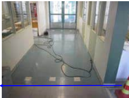
Kuva 12: Yleiskuva aulatilasta välikäytävälle, putkikanaalin sijainti
