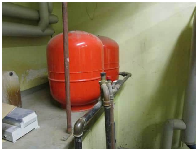
Kuva 6.49 Lämmityksen paisunta-säiliöt
