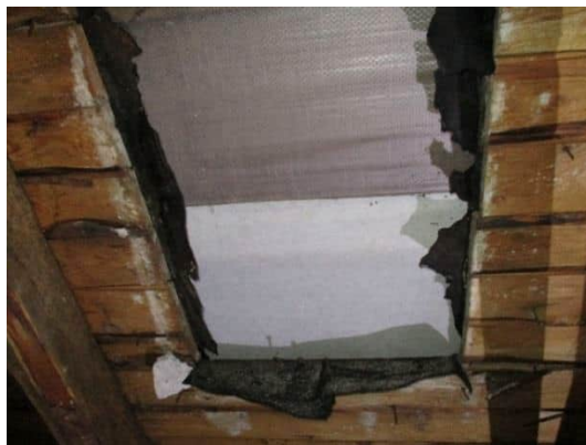
Kuva 72. Näyte aluskermistä (PAH2), ei sisällä PAH-yhdisteitä yli haitallisen määrän raja-arvon.
