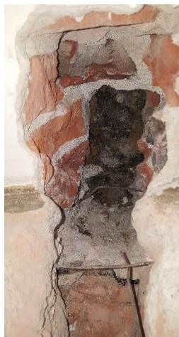
Kuva 14. Rakenneavaus välipohjaan ja ulkoseinään, VP2 ja US2.
