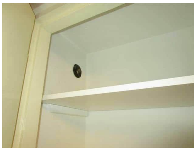
Kuva 6.79 Vanhat korvausilmareiät on paikattu.
