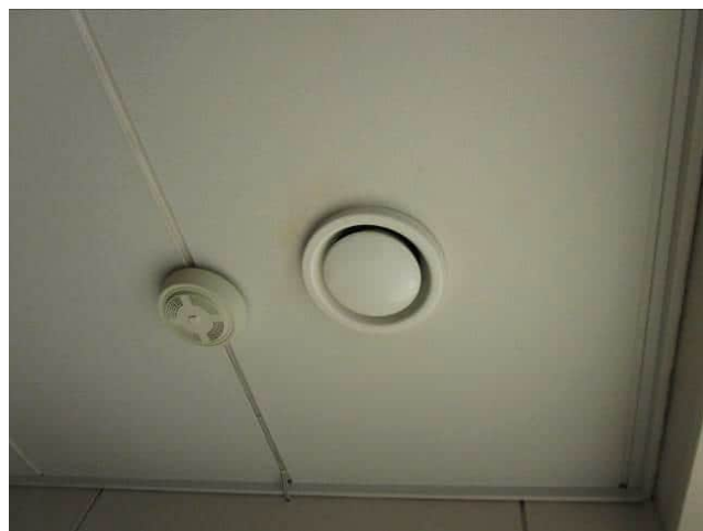
Kuva 6.62 Poistoilmapäätelaitteita.
