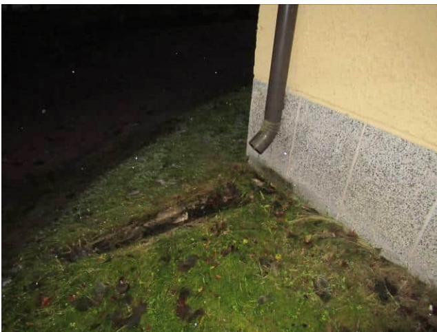
Kuva 6.1 Kattovedet ohjataan betonikouruun syöksytorvien kautta osassa rakennusta.
