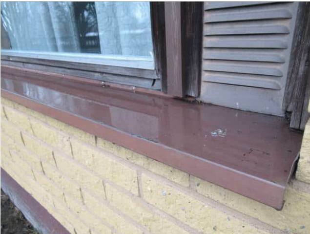
Kuva 6.24 Ikkunapeltien kaadot ovat paikoin puutteelliset.
