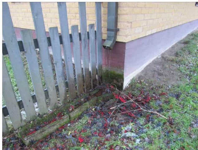
Kuva 6.17 Kattovedet kastelevat sokkeliä.
