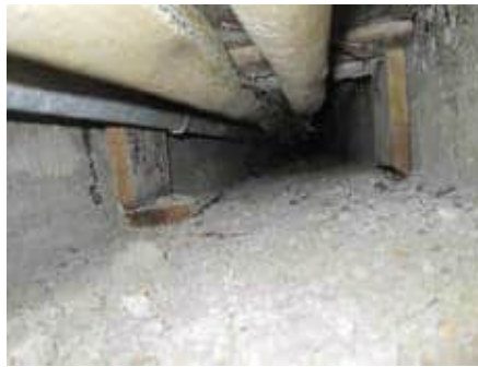
Kuva 10: Putkikanaalin avauspiste B, käytävän suuntaan kuvattuna.
