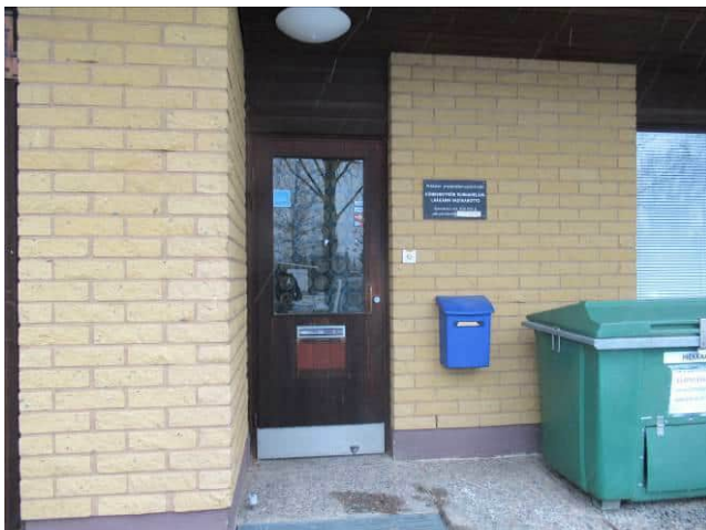
Kuva 6.18 Tiiliverhous ja paneloinnit ovat pääosin siistissä kunnossa.
