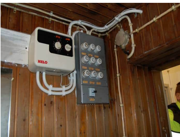
Kuva 6.90 Saunaosaston ryhmäkeskus ja kiuas-keskus
