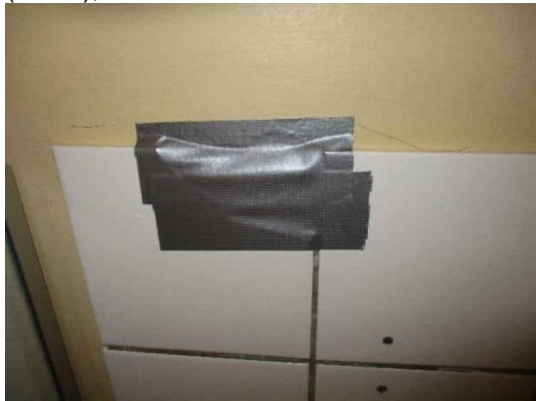
Kuva 49. Näyte seinälaatatista, liimasta ja saumalaastista (ASB3), ei sisällä asbestia.
