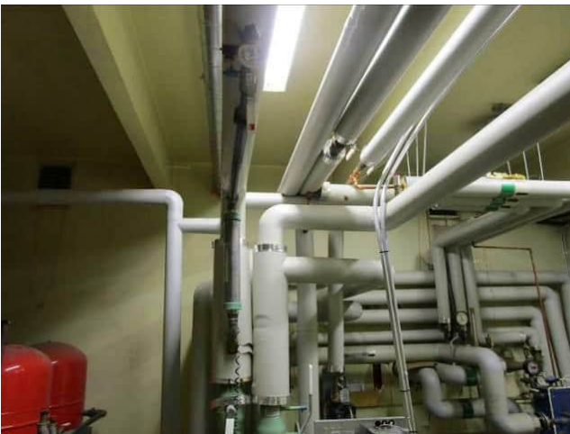
Kuva 6.54 Lämmönjakoputkistoa.
