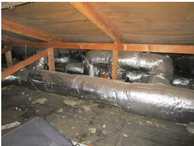
Kuva 6.53 Siistää lämmöneristystä alumiinipinnoituksella
