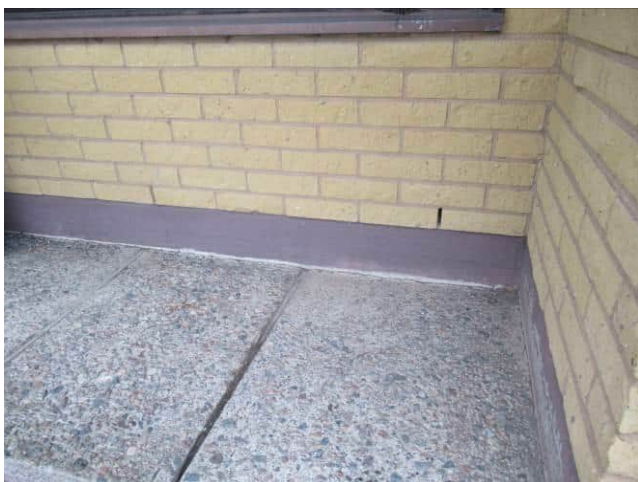
Kuva 6.20 Alimman tiilirivin pystysaumoista osa on jätetty tuuletuksen varmistamiseksi saumamatta.
