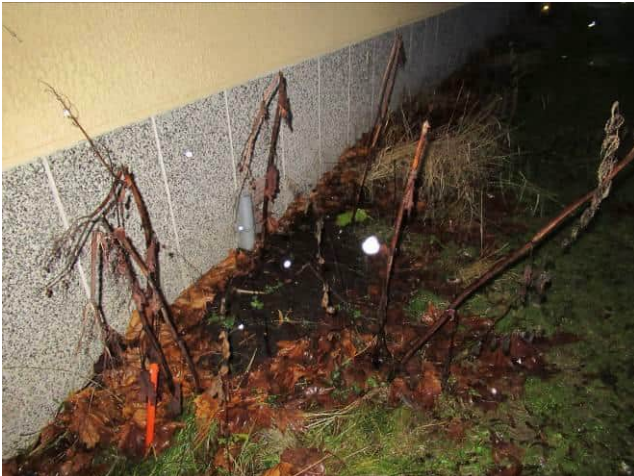
Kuva 6.14 Yleiskuva rakennuksen sokkelista.
