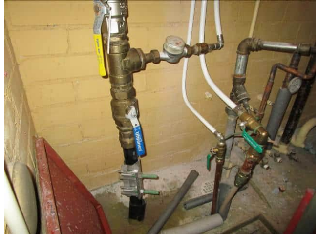
Kuva 6.44 Tonttivesijohto oli hyvässä kunnossa
