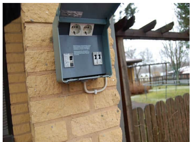
Kuva 6.77 Autolämmityspistorasiakotelo
