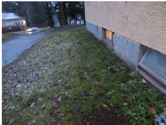
Kuva 6.10 Nurmialue ulottuu rakennuksen seinään asti.
