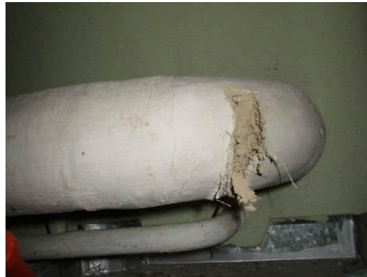
Kuva 54. Näyte putkieristeestä (ASB7), ei sisällä asbestia. Suositellaan kuitenkin käsiteltäväksi asbestipitoisena.
