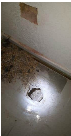
Kuva 13. Rakenneavaus välipohjaan ja ulkoseinään, VP1 ja US1.
