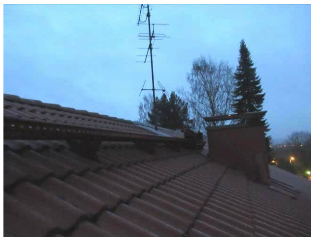
Kuva 6.36 Katolla on asianmukaiset kulkusillat.
