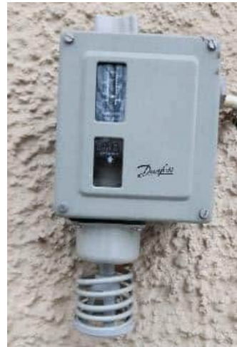
Kuva 92. Tehonvaihtotermostaatti.
