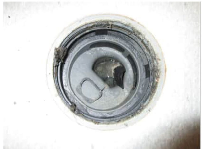
Kuva 6.48 Uusittu lattiakaivo
