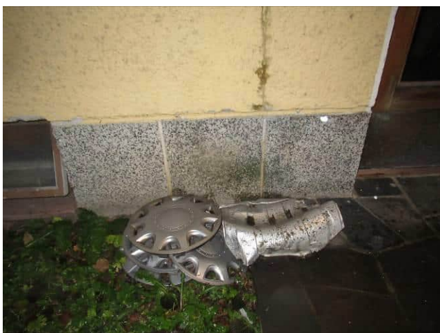
Kuva 6.5 Pääoven katokselta tulevat vedet kaste- levat rakennuksen seinää ja betonilaattaa.
