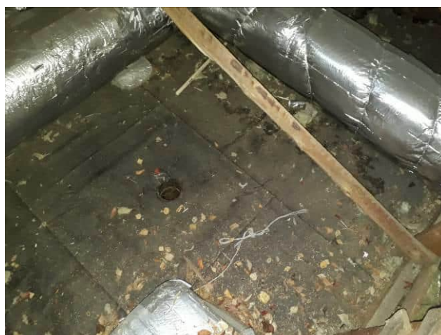
Kuva 6.32 Vanha kate on jätetty rakenteen sisään.
