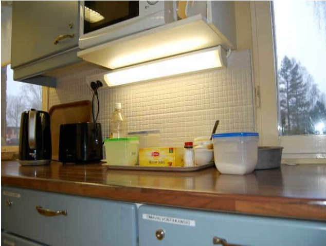
Kuva 6.72 Keittiön työtason valaistusta
