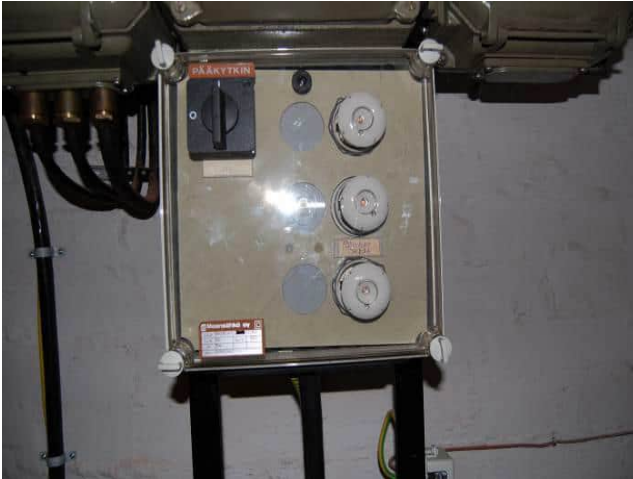
Kuva 6.80 Kiinteistön pääsulakkeet.
