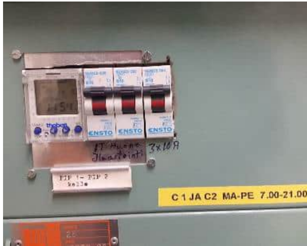
Kuva 91. Huippuimureiden kellokytkin.
