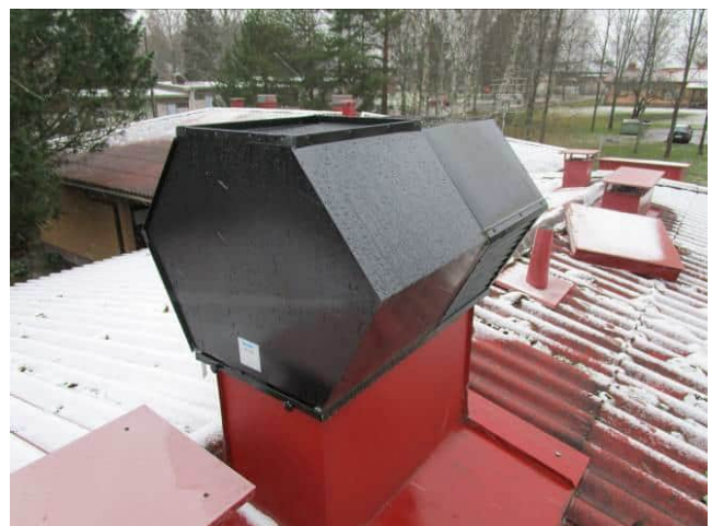
Kuva 6.60 Ilmanvaihtokoneen yhdistelmähuuva
