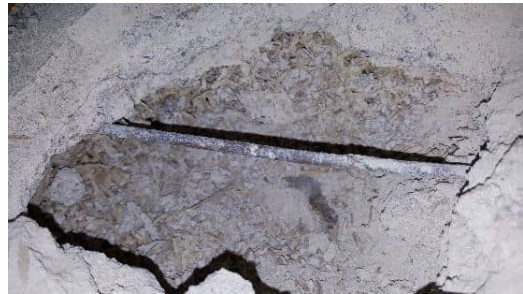
Kuva 10. Rakenneavaus alapohjaan, AP1.
