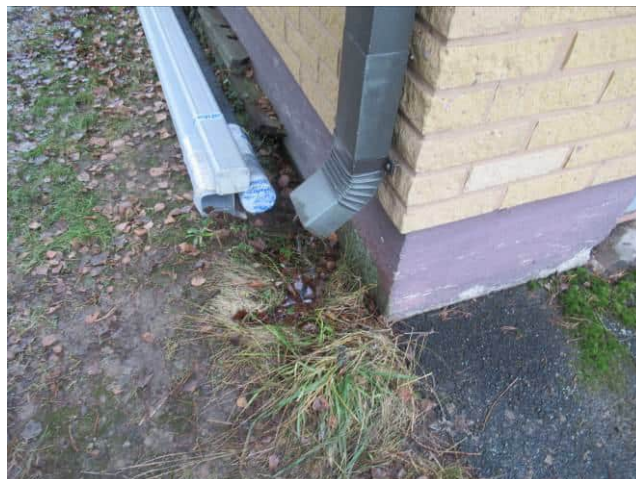
Kuva 6.2 Kattovedet ohjataan syöksytovien kautta suoraan maahan.
