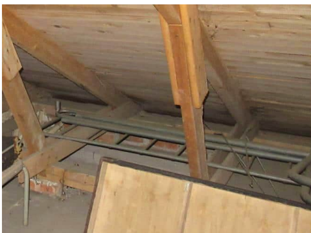
Kuva 6.30 Räystäään suuntainen tuuletusrako.
