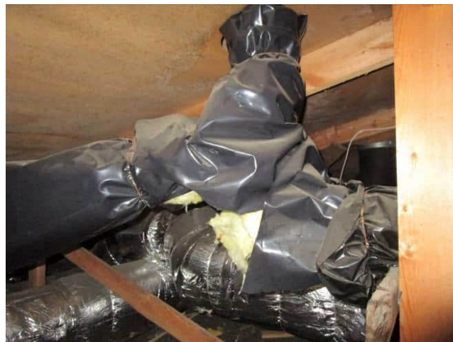
Kuva 6.54 Tuuletusviemäri eristys
