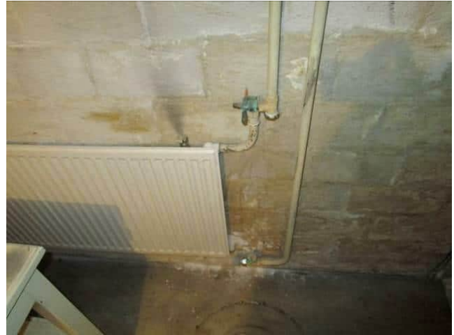
Kuva 6.53 Tyydyttävässä kunnossa olevat patterin kytkentäjohdot
