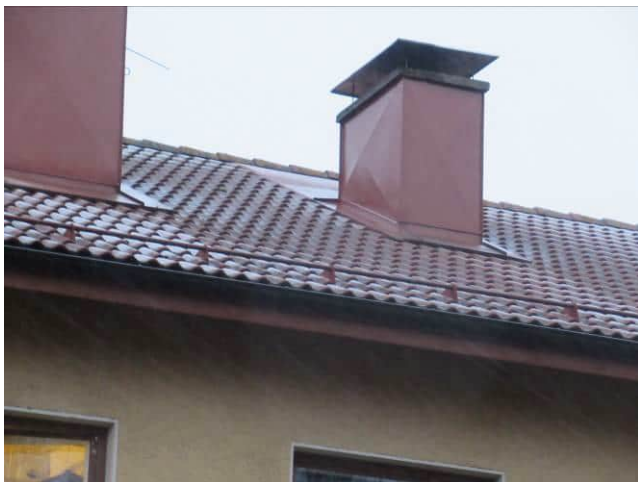
Kuva 6.37 Rakennuksen pääoven puolella on lumiesteet koko lappeen matkalla.
