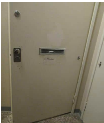
Kuva 6.38 Kellarin metallinen väliovi porrashuoneeseen.
