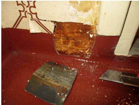
Kuva 59. Näyte wc-tila muovimatosta ja liimasta (ASB 12), ei sisällä asbestia.
