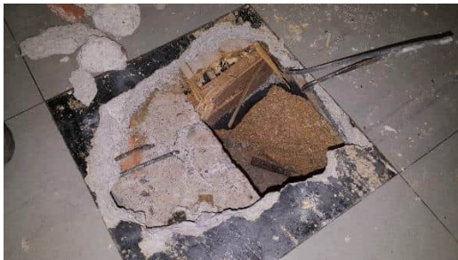
Kuva 11. Rakenneavaus välipohjaan, VP3.
