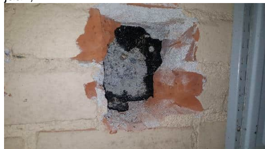
Kuva 15. Rakenneavaus kellarin seinään, KS1.
