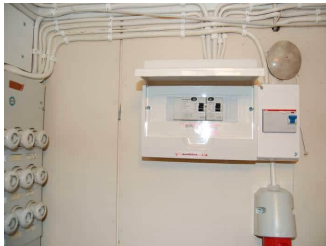
Kuva 6.67 Pääkeskukselle jälkikäteen lisätty lisäosa
