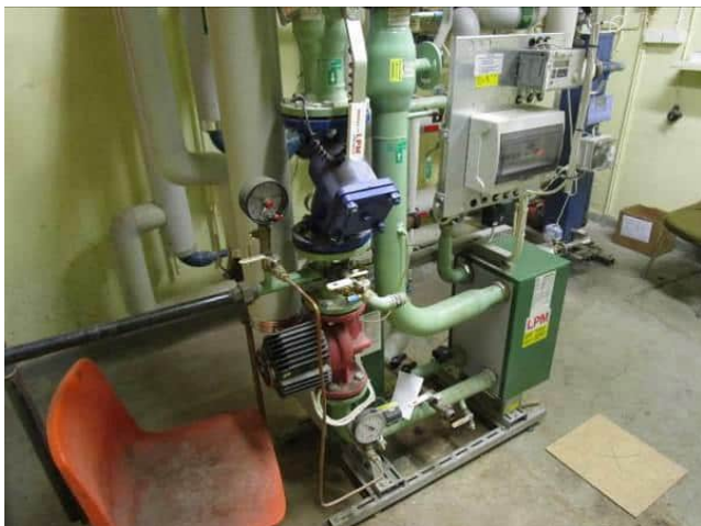
Kuva 6.48 Lämmönjakokeskus
