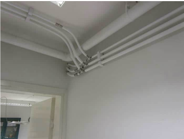
Kuva 6.45 Uusittua komposiittiputkea eläinlääkäriloissa
