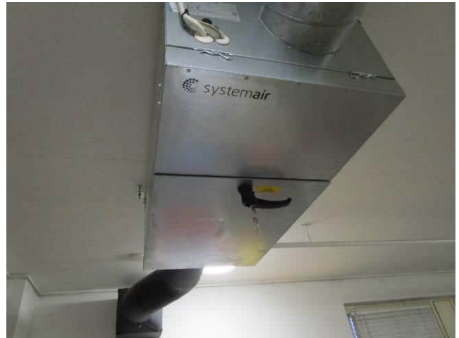
Kuva 6.58 Systemair tuloilmakone eläinlääkäritilalle
