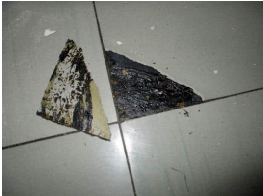
Kuva 47. Näyte lattian mustasta liimasta (ASB2), sisältää asbestia.
