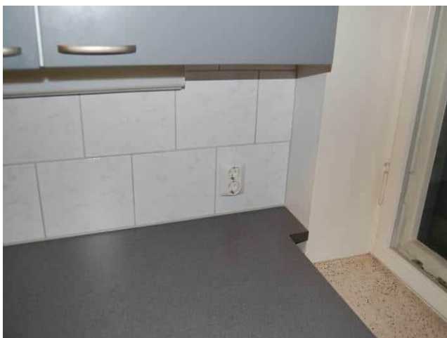
Kuva 6.94 Uusittuja huoneiston asennuksia
