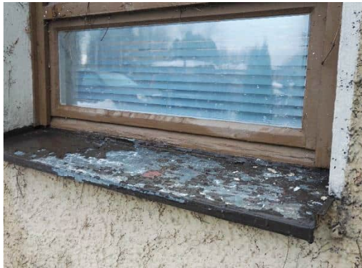
Kuva 81. Näyte ikkunapellin maalista (Pb7), sisältää lyijyä.
