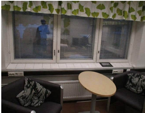
Kuva 65. Näyte ikkunalaudan laatasta ja laasteista (ASB11), ei sisällä asbestia.
