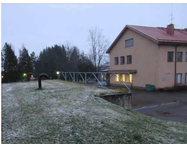
Kuva 6.12 Viereisen kiinteistön autotali/varastorakennuksen päällä välissä on tippumista estävä kaide.
