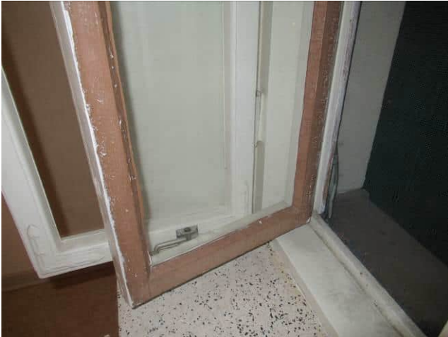
Kuva 6.20 Ikkunat ovat kaksipuitteisia puuikkunoita.
