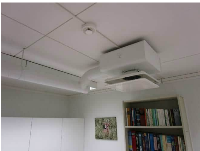
Kuva 6.61 Tuloilmapäätelaitteita.
