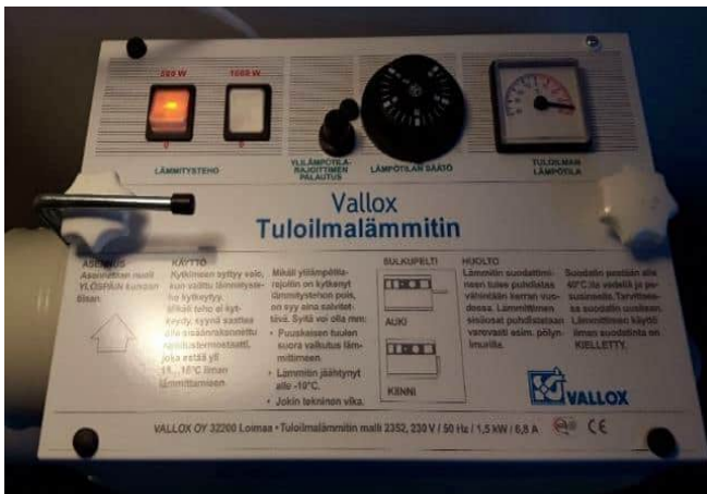
Kuva 89. Korvausilmalaite.
