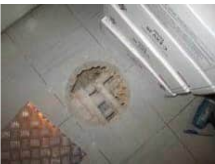
Kuva 7: Putkikanaalin avauspiste B:
