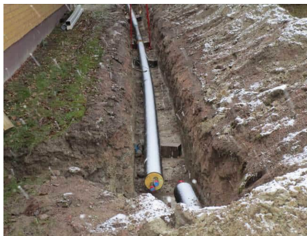
Kuva 6.38 Uutta kaukolämpölinjaa rakennukseen
