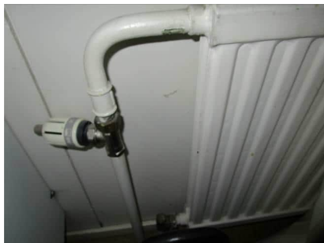
Kuva 6.40 Kytkentäjohto patterille ja iäkäs termostaatti-osa
