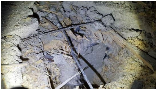
Kuva 9. Rakenneavaus yläpohjaan, YP1.
