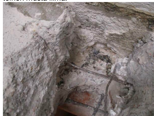
Kuva 64. Näyte välipohjan sivelestä (ASB 15), ei sisällä asbestia.
