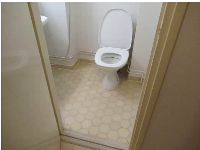
Kuva 6.44 Wc-tilassa on todennäköisesti alkuperäinen lattialaatoitus.
