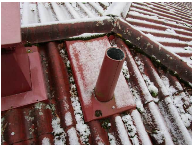
Kuva 6.55 Eristämätön tuuletusviemäriin pää vesikatolla.
