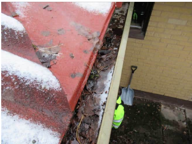
Kuva 6.33 Räystäskourut ovat puhdistamatta.
