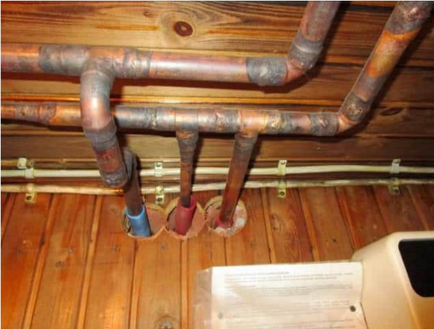
Kuva 6.64 Eristämättömiä käyttövesiputkia.
