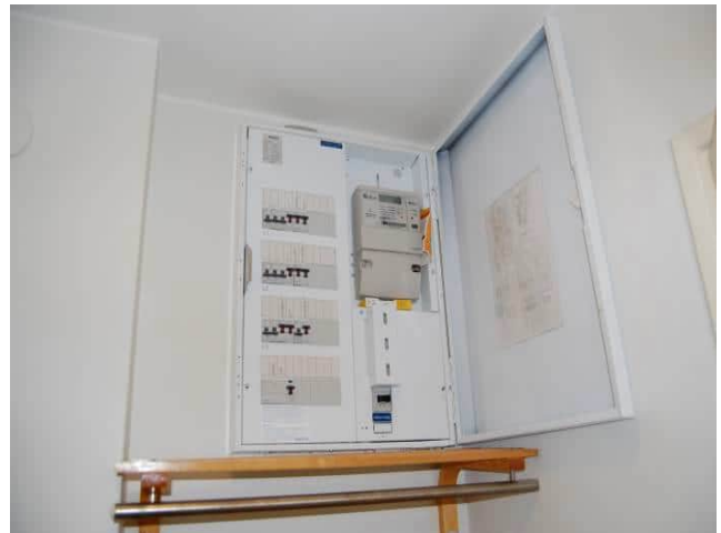
Kuva 6.86 Uusittu ryhmäkeskus
