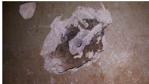
Kuva 12. Rakenneavaus kellarin alapohjaan, KAP2.
