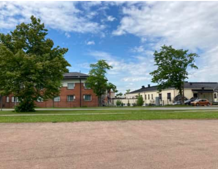
Härkikujan länsipuolella sijaitseva sairaala
