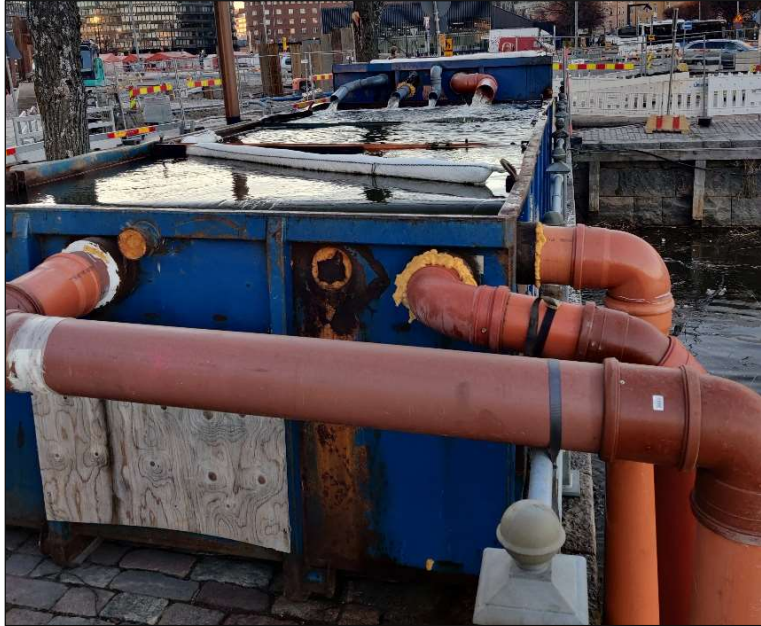
Kuva 19. Hulevesien työmaan aikaiseen viivyttämiseen ja suodattamiseen käytettävä vesitiivis laskeutuskontti. Konttiin pumpataan vedet työmaan kaivannosta. Konytiin on toteutettu väliseiniä hidastamaan veden virtausta ja edistämään kiintoaineksen laskeutumista. Järjestelmässä on kaksi konttia peräkkäin. Jälkimmäiseen konttiin ohjataan vedet ensimmäisen kontin pinnalta. Kuva © Destia 2024.
