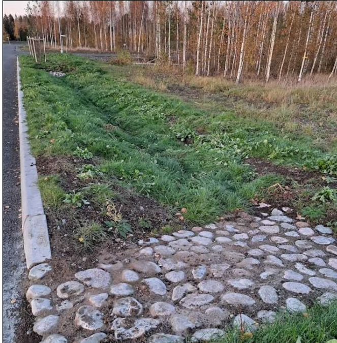
Kuva 13. Esimerkki hulevesien johtamirakenteesta kadun viheralueella. Hulevedet kootaan kadulta reunakivilinjan madalletusta kohdasta reunaojaan. Kuva © Destia 2024.
