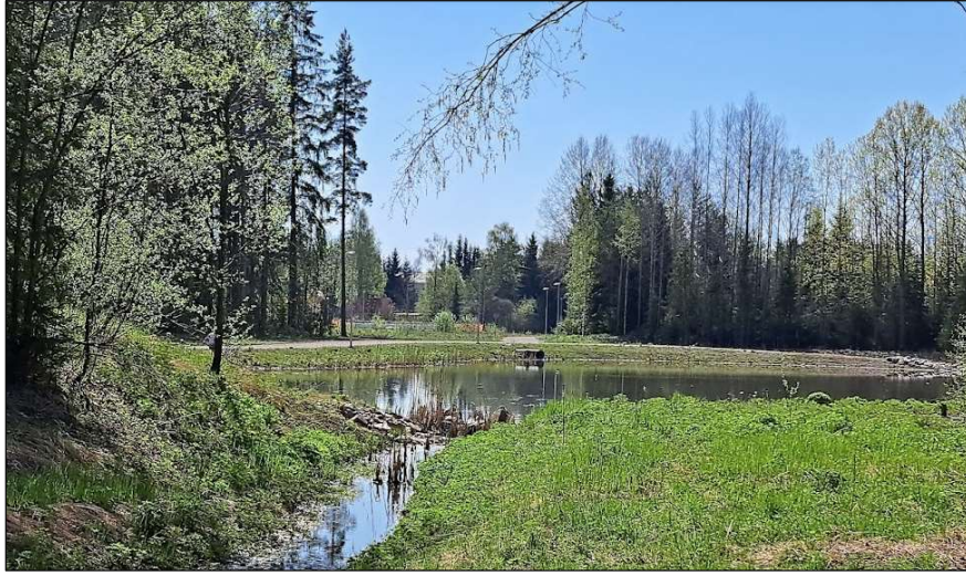
Kuva 17. Esimerkki hulevesialtaasta Järvenpäästä. Kuvassa näkyvän altaan koko on noin 500 m 2 . Altaan ympäristö on suunnitelmassa osoitettu osittain metsitettäväksi ja osittain niittyalueeksi. Jalankulun ja pyöräilyn väylät ovat asfalttipäällysteiset ja altaaseen liittyvät huoltokäytävät kivituhkapintaiset. Kuvan taka-alalla on toinen altaan osa, johon on rakennettu noin 100 m 2 biosuodatuskenttä. Kuva © Destia Oy 2024.
