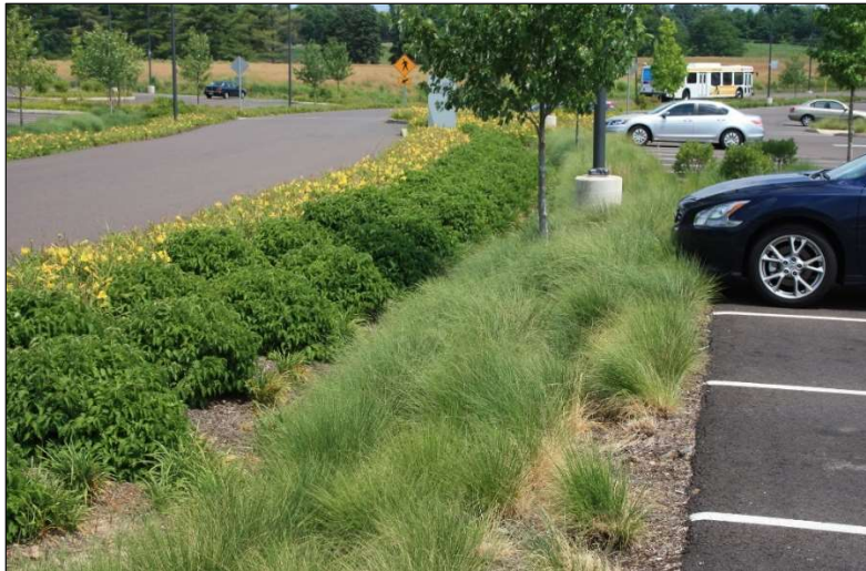
Kuva 14. Esimerkki hulevesien imeyttämiseen käytetystä viherkaistasta. Hulevedet imeytetään maaperään kaistan vesijuoksun kohdalta. Vesijuoksun kohdalla rakennekerrokset ovat hyvin vettä läpäiseviä. Pohjalle on toteutettu suodatuskerros hiekasta. Maaperä on hyvin vettä läpäisevää. Kuva © Montgomery County Planning Commission CC BY 2.0.
