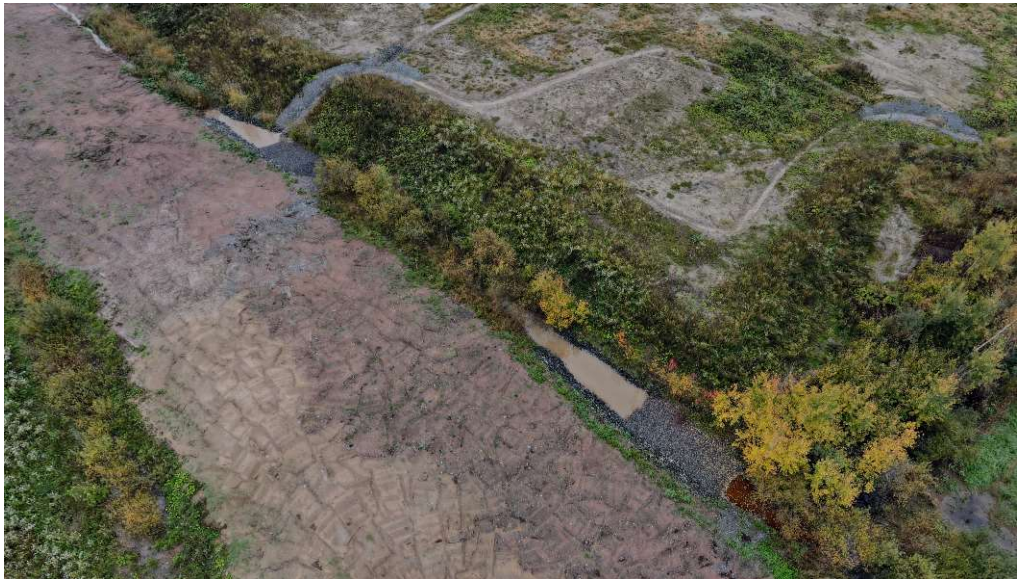
Kuva 11. Suunnittelualueella sijaitseva valtatie 3 vanha tiepohja, jonka sivuojaan kautta hulevedet purkavat suunnittelualueen ulkopuolelle. Sivuojaan on toteutettu Hämeenkyrönväylän rakentamishankkeen aikana kaksi hulevesien viivytysallasta. Kuva © Destia Oy 10/2023.
