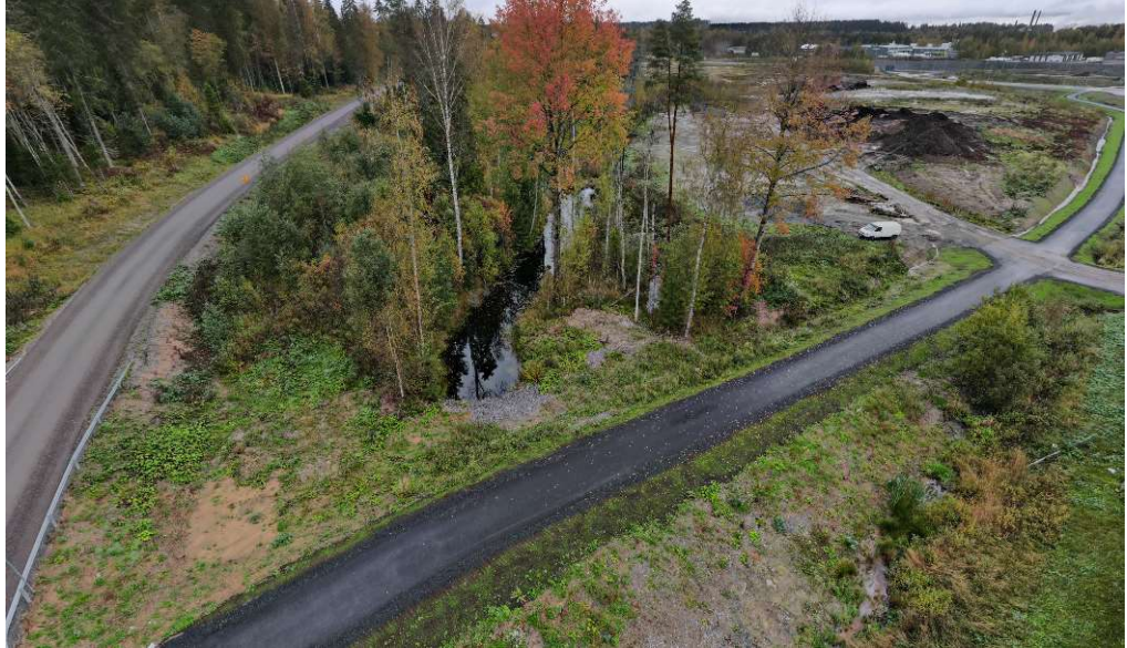
Kuva 10. Suunnittelualueen eteläreunalla sijaitseva Häijääntien ja jalankulku- ja pyöräilyväylän allittava rumpu, jonka kautta pintavesiä virtaa suunnittelualueelle etelän suunnasta. Kuva © Destia Oy 10/2023.
