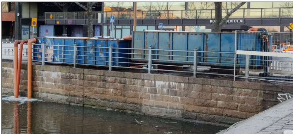
Kuva 20. Hulevesien työmaan aikaiseen viivyttämiseen ja suodattamiseen käytettävä laskeutuskontti. Vedet tulisi johtaa mahdollisuuksien mukaan kasvillisuuspainanteeseen. Purkuvesien suodattamisen parantamiseksi purkupäähän (kasvillisuuspainanteeseen) voidaan asentaa esimerkiksi tarvittaessa vaihdettava suodatinkangas tai väliaikainen suotopato. Kuva © Destia 2024.
