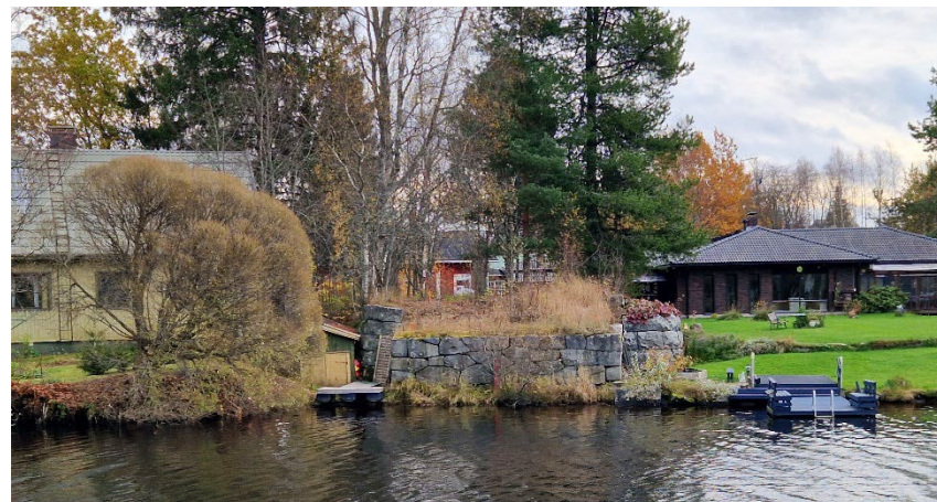
Kuva 10. Pappilanjoen silta on purettu, mutta silta-arkut ovat edelleen olemassa joen molemmilla rannoilla.
