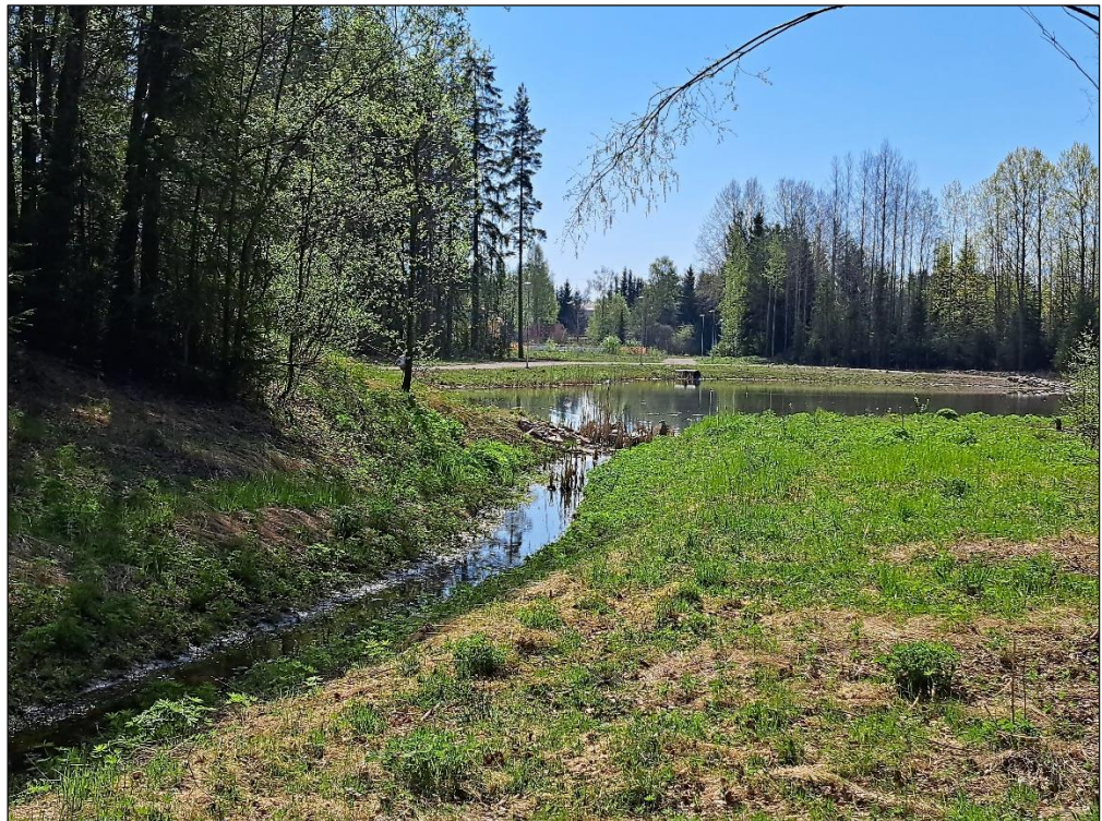
Kuva 11 A, B ja C. Esimerkkejä viivytysaltaasta. Kuva © Destia Oy 2024.
