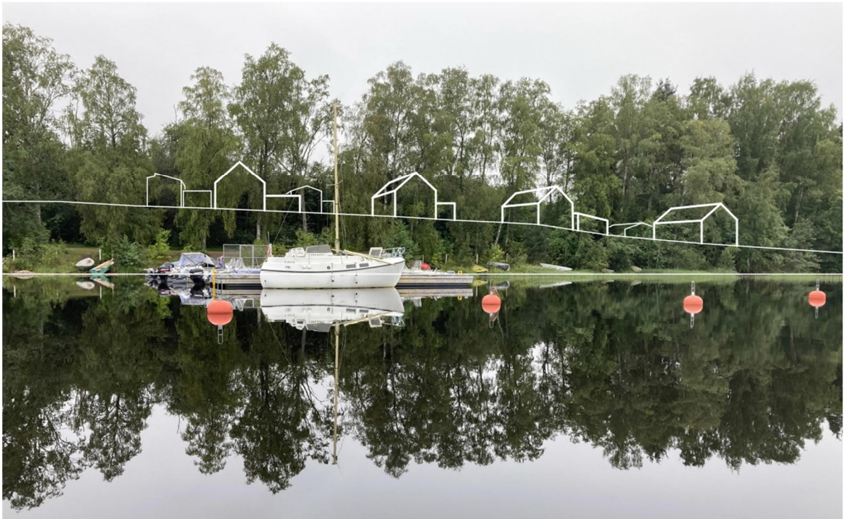
Näkymä pohjoisesta Kyrösjärveltä. Rakentaminen sijoittuu pääosin rantapuuston taakse, rakennuksista pieniä osia voi näkyä järvelle. Kuvassa rakennukset ovat ns. rautalankamallina ja saman kokoisena kuin 3D-mallissa.
