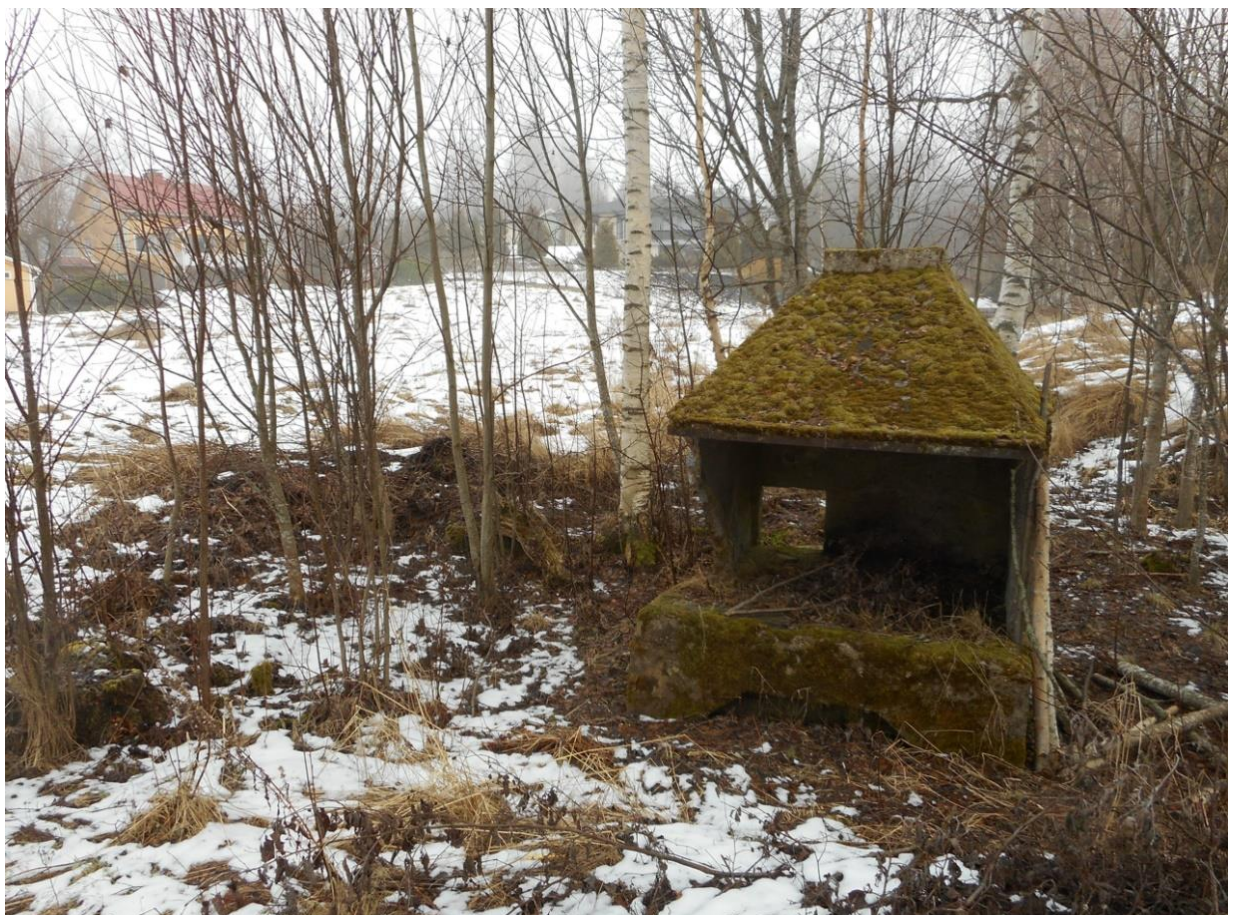
Kuva 12. Pajarakennuksen kivrakenteinen alusta ja kupu. (Hämeenkyrö)
