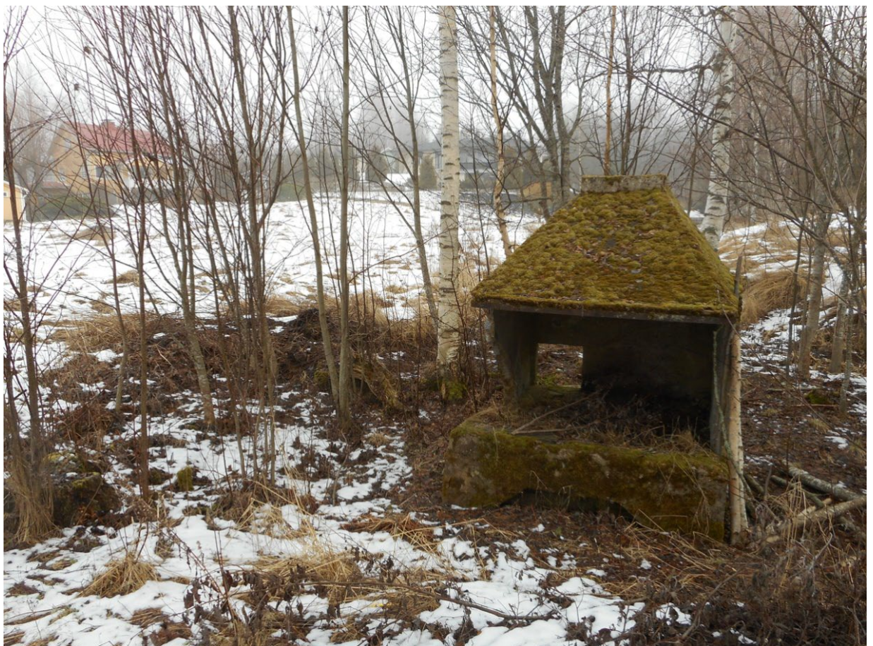
Kuva 12. Pajarakennuksen kivirakenteinen alusta ja kupu. (Hämeenkyrö)
