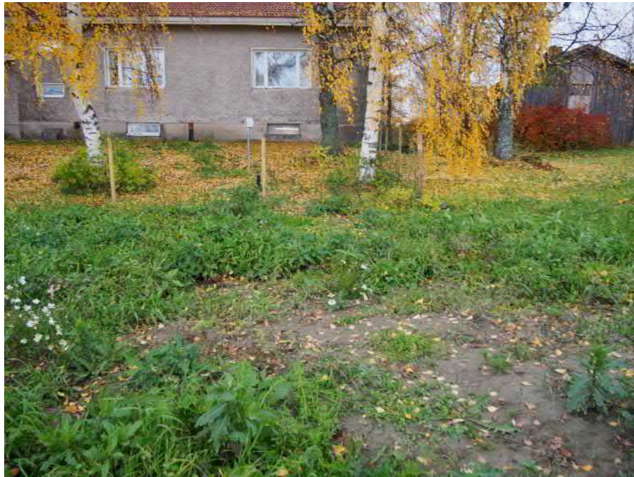
Kuva 4. Maastossa näkyvien jälkien perusteella talon eteläpuolella oli kaivettu vesihuoltolinjaa ilmeisesti aikaisemmin kesän 2019 aikana.
