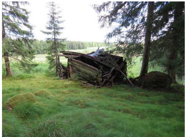
Romahtanut lato pellon reunassa, kuva pohjoiseen.
