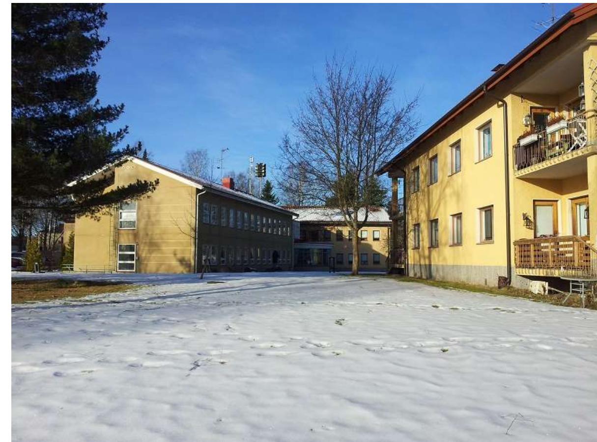
Vasemmalla vuoden 1976 ilmakuvaus pohjalta laadittu peruskartta vuodelta 1982 ja oikealla ylhäällä päällepainatuksena toteutettu vuoden 1989 peruskartta. MML 212210. Alakuvassa kunnantalon uudissiipi, keskellä vanha kunnantalo ja oikealla virkailijoiden asuinrakennus.
