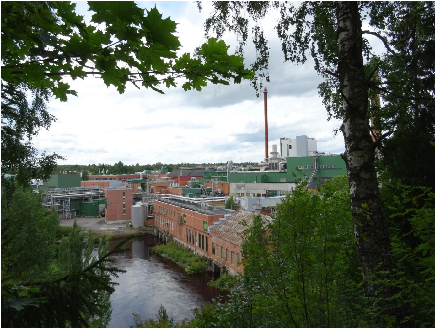
Kyrökoski ja tehtaat, koski pauhaa vielä kesäviikonloppuisin näytösluonteisesti.
