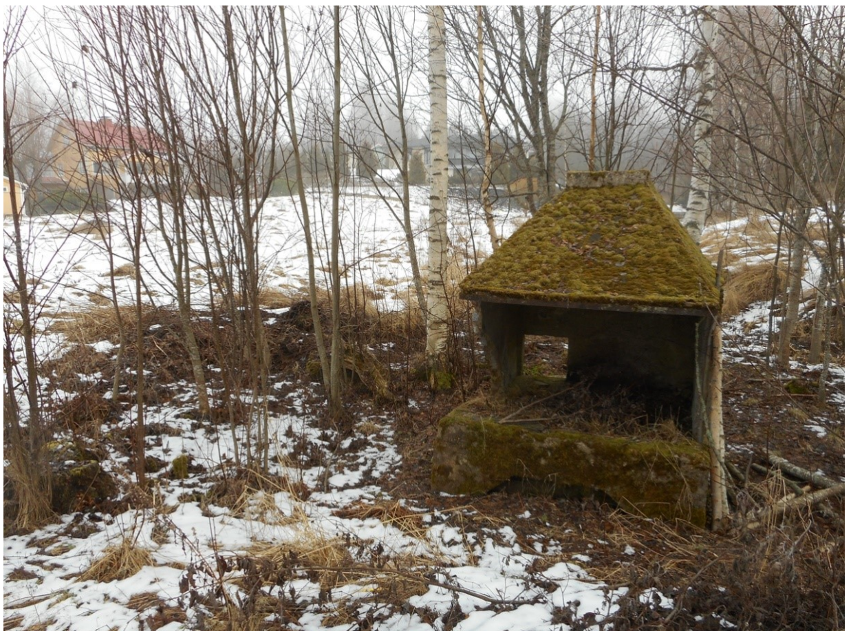
Kuva 12. Pajarakennuksen kivrakenteinen alusta ja kupu. (Hämeenkyrö)
