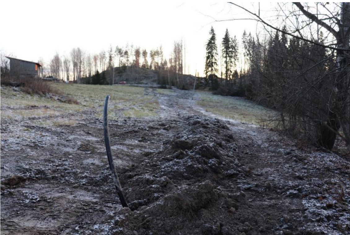
Kuva 43. Kukkasmaan talon eteläpuolella oli asennettu maakaapeli.
