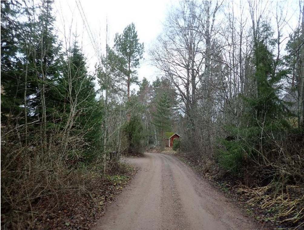
Kuva 15. Lemmakalan kylätontin läpi kulkee tie. Tieleikkaus on voimakkaasti leikattu.
