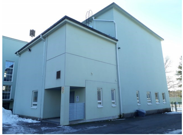
Rakennuksen kolliskulmassa vuoden 2009 laajennus ja uusi sisäänkäynti päiväkotia varten. Toisessa kerroksessa iv-konehuone. Samassa yhteydessä tehtiin uusi ikkuna sisäänkäynnin viereen ja neljä ikkunaa vanhan osan pohjoispäättyyn.
