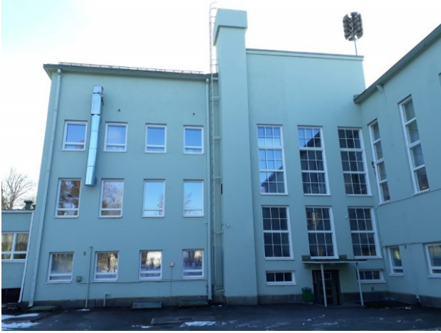
Portaikon pohjoisseinällä on selvimmin nähtävissä ikkunoiden uusiminen. Uusissa ikkunoissa on ulkopinnassa ristikko puitejaon sijaan.
