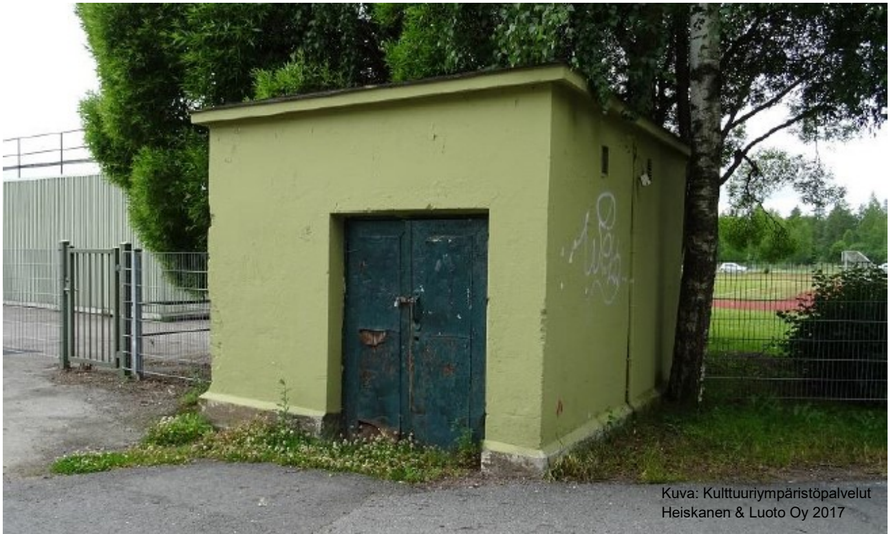
Tekniikkarakennus / muuntamo alkuperäisessä asussaan, Koskilinnankujan länsipuolella.
