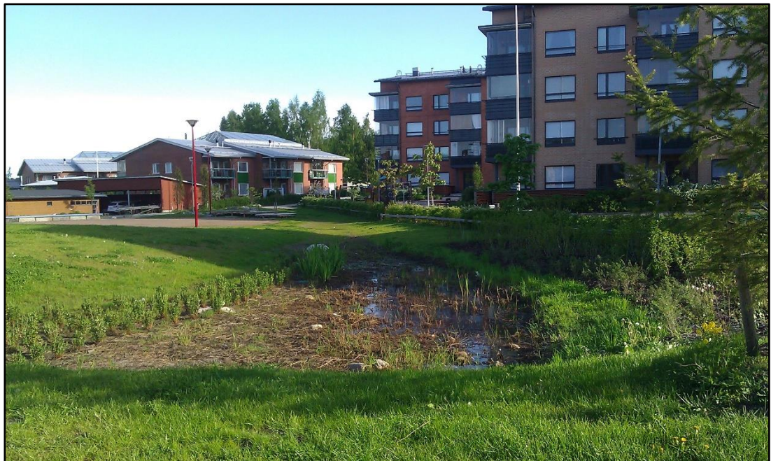
Kuva 6 Viivytyspainanne Tampereen Muotialassa (FCG).
